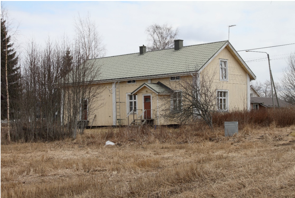
Kuva 55. Sääksjärven entisen osuuskaupan pihan puoleinen julkisivu.
