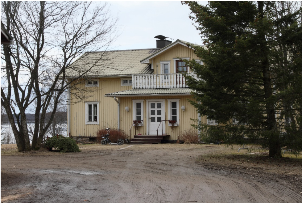
Kuva 40. Ylituvan asuinrakennuksen pihan puoleinen julkisivu.
