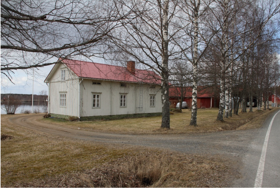
Kuva 19. Vanhapihasta aukeaa useampia viehättäviä näkymiä tieltä vanhojen talojen pihapiirien läpi Sääksjärvelle.
