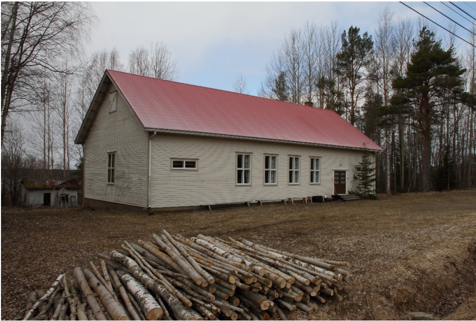
Kuva 49. Sääksjärven entisen järjestötilan Sääksjärventien puoleinen julkisivu.
