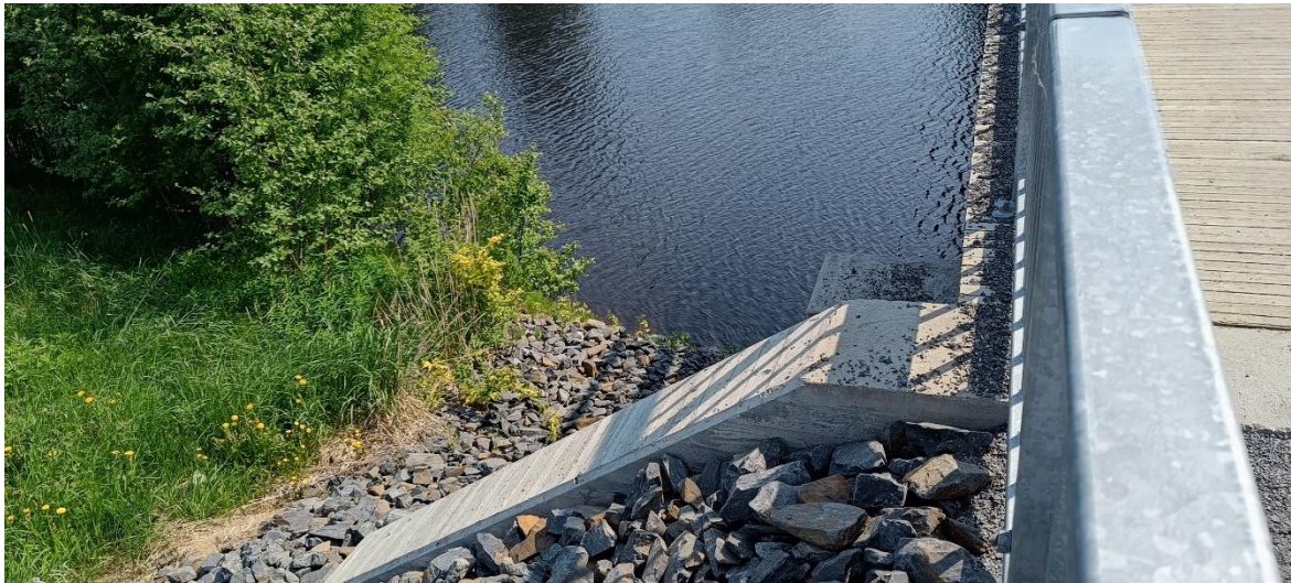
Kuva 10 Jukkalan kevyen liikenteen sillan pengertä pohjoisen puolelta.
