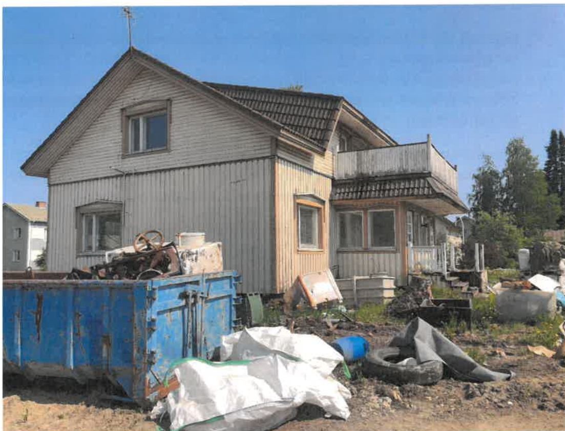
Kuva 2 Tulevan hybridikeskuksen tontilla sijaitseva purettava rakennus, kuvattuna Lehtokujan puolelta
