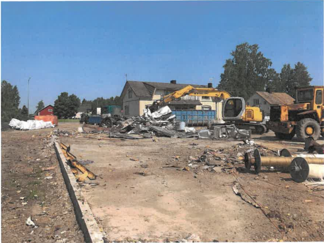
Kuva 3 Hybridikeskuksen tontti nykytilassaan. Kuva otettu tontin keskiosasta pohjoiseen päin.
