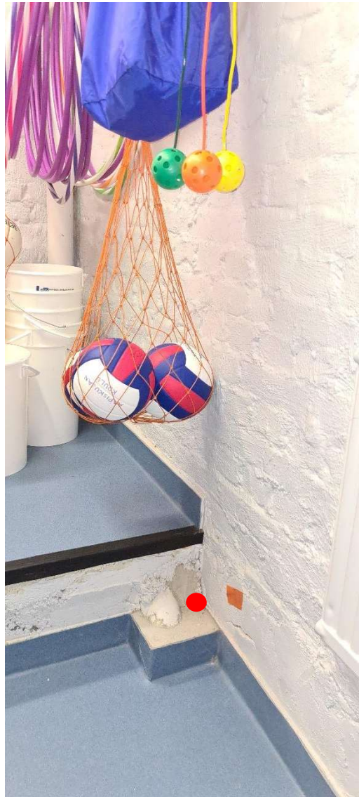
12. Ilmaisu lattiaan, läpiviennin kohdalle
