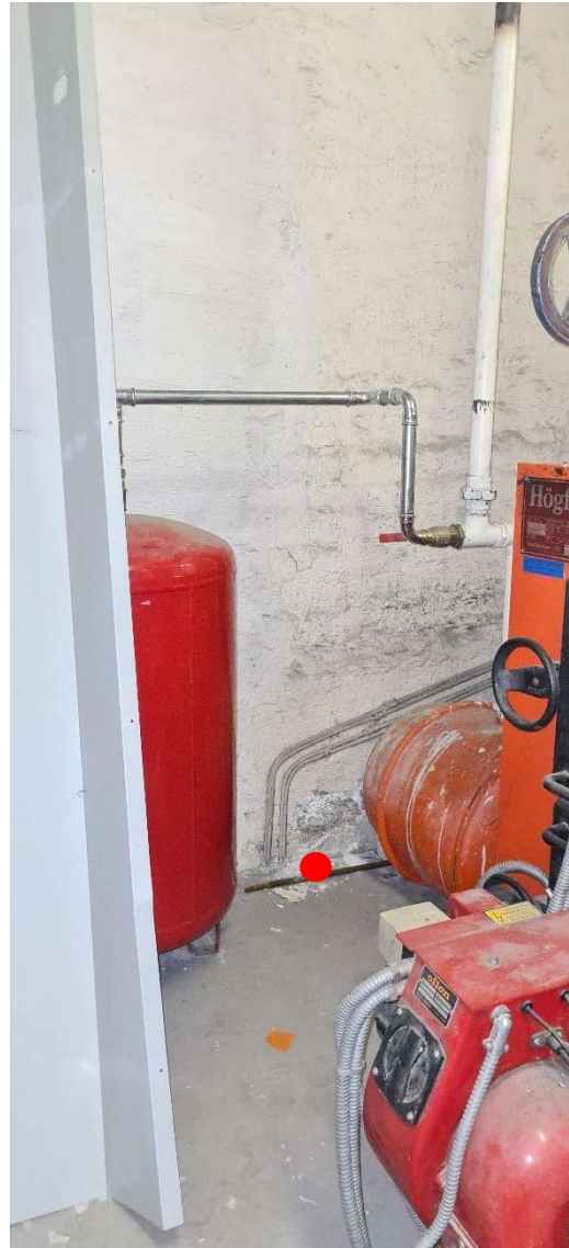
14. & 15. Ilmaisut lattian ja seinien liitoskohtiin
