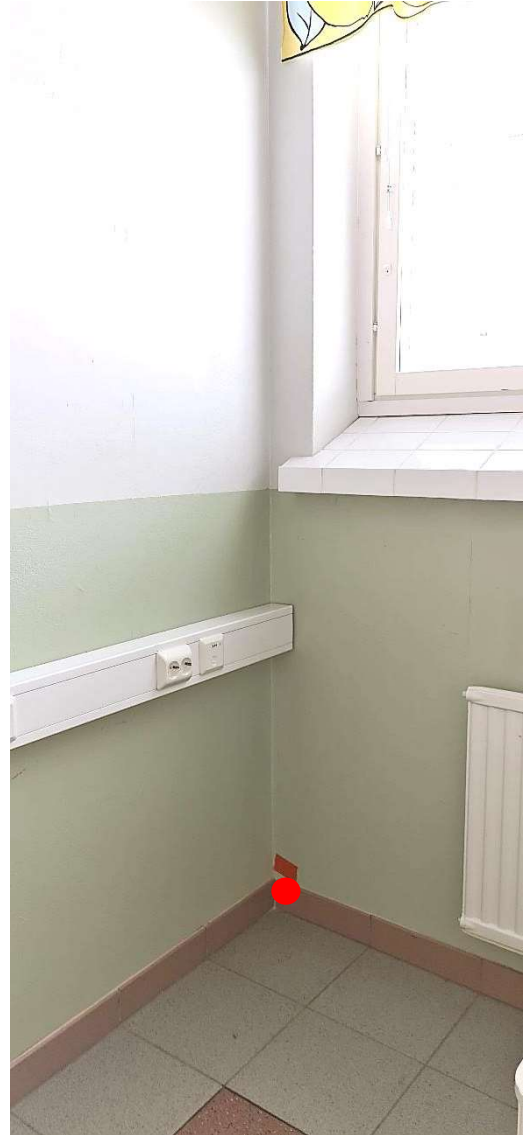
28. Ilmaisu lattian ja maanvastaisen seinän liitoskohtaan
