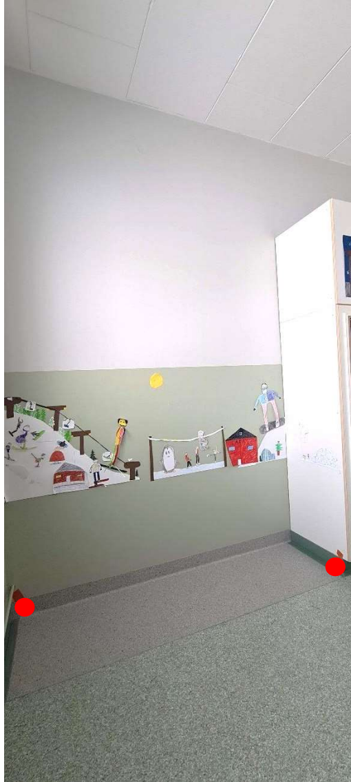
6. Ilmaisu lattia ja koteloinnin liitoskohtaan sekä putkien läpivientien kohdille
