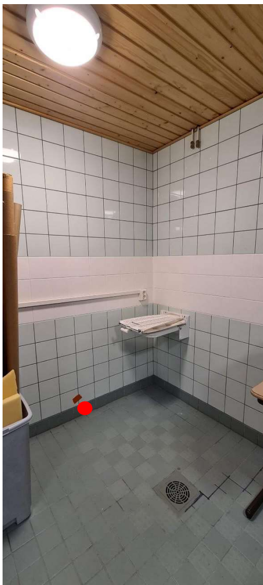
18. Ilmaisu varaston lattian ja maanvastaisen seinän liitoskohtaan
