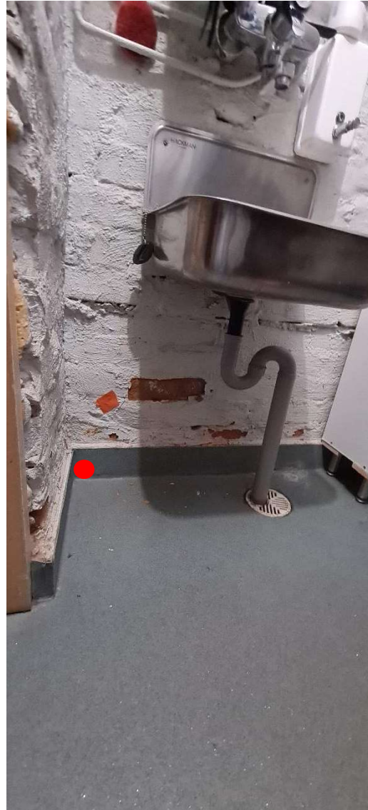
20. Ilmaisu maanvastaisen seinän ja lattian liitoskohtaan
