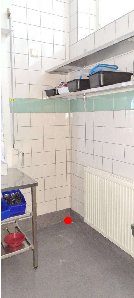
29. Ilmaisu lattian ja maanvastaisen seinän liitoskohtaan
