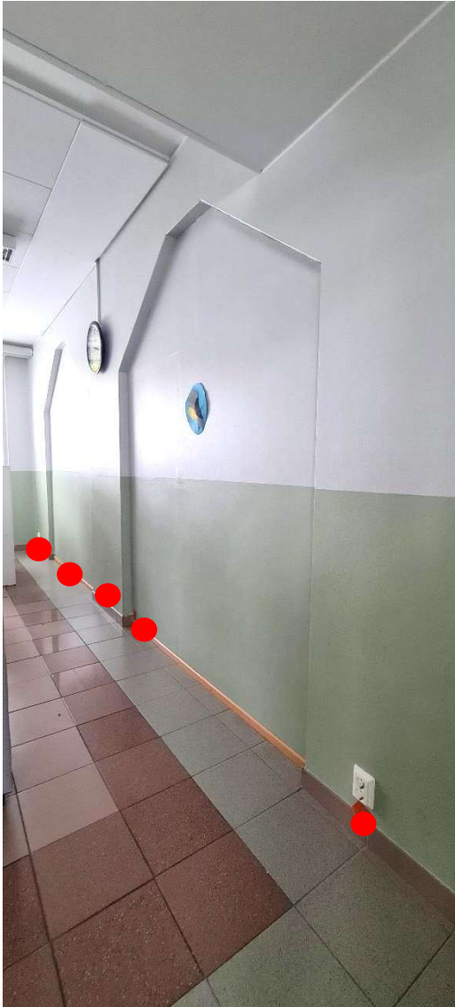
27. Ilmaisut lattian ja väliseinän liitoskohtiin
