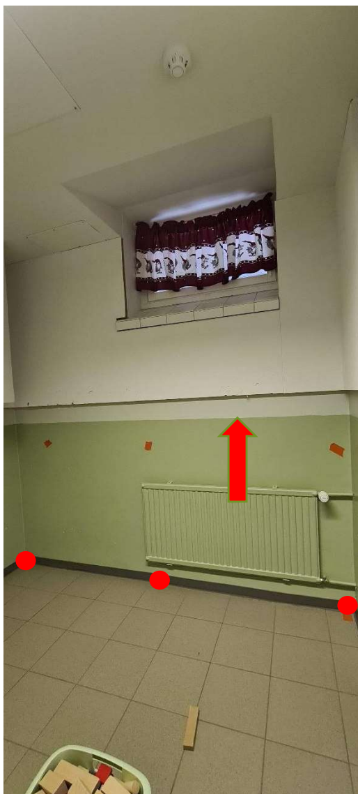
22. Ilmaisut lattian ja maanvastaisen seinän liitoskohtiin
