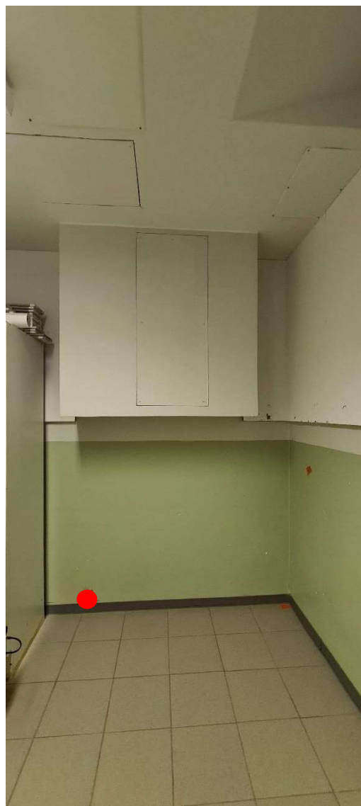
23. Ilmaisuus lattian ja väliseinän liitoskohtaan
