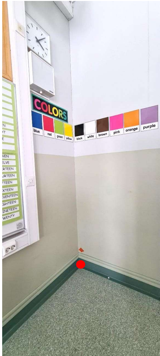
5. Ilmaisuu lattiaan ja ulkoseinän / koteloinnin liitoskohtaan
